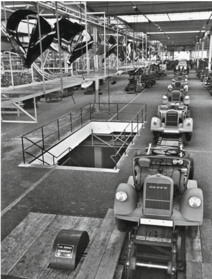
Montage der Lkw »Blitz« 3,5 (2 bzw. 2,5-Tonner mit flachem Kühlergrill) im neuen Opel-Lkw-Werk in Brandenburg an der Havel, 1936
