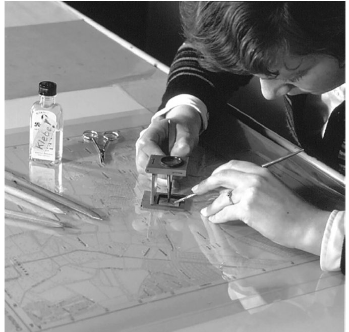
Aufkleben von Schriftzügen auf transparentem Film
