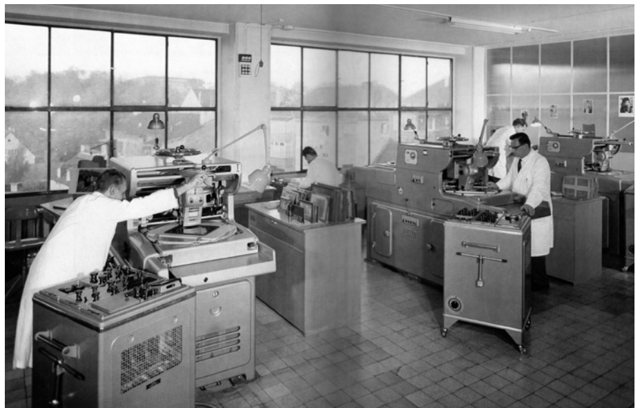
Gravieren von Klichs auf dem Varioklischographen K181, 1960er (Verein der Freunde und Förderer Technische Sammlung Dr.-Ing. Rudolf Hell in Kiel e.V./Hell Verein Kiel)
