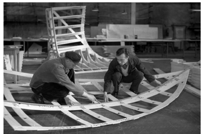
Schiffbauer fügen Spantenschablonen und Kastenmodelle zusammen, Deutsche Werft AG, 1965 (Berufsbild Schiffbauer Eisen, Foto Wolfgang Etzoldt)
