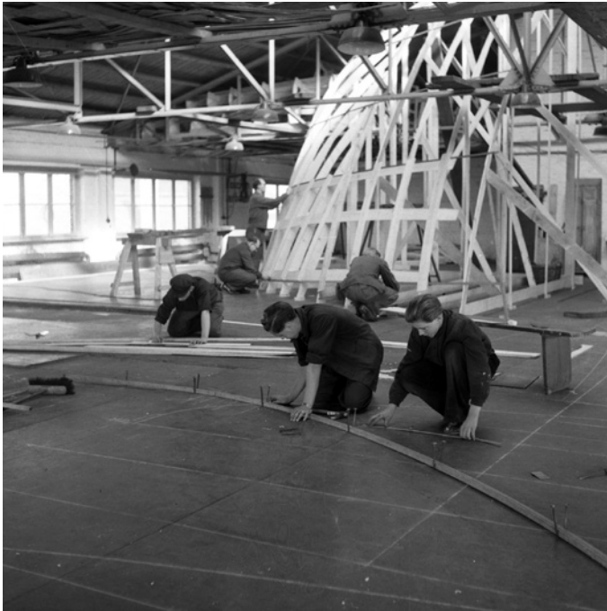
Austraken der Linien auf dem Schnürboden für ein großes Kastenmodell (um 1955)
